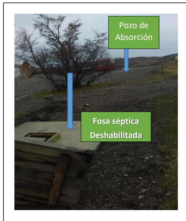
Figura 3. Detalle del sistema de tratamiento aguas de Lavandería.
